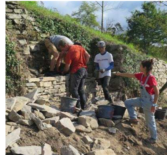
Trockenmauerbau, Spay
