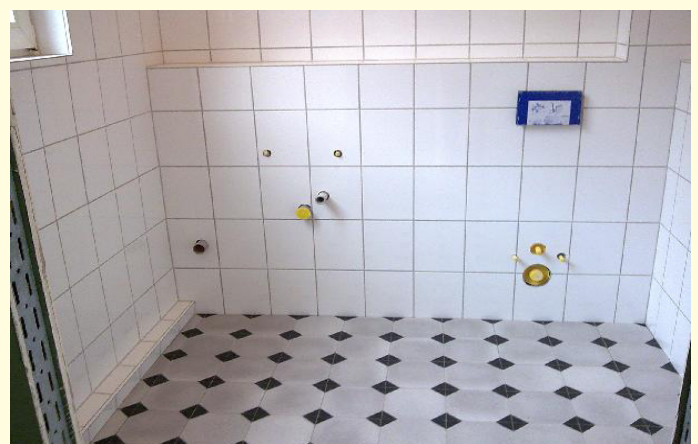
Sanierung Kaub Toiletten
