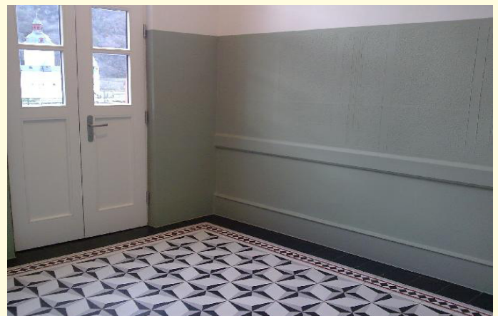
Sanierung Kaub Wartesaal
