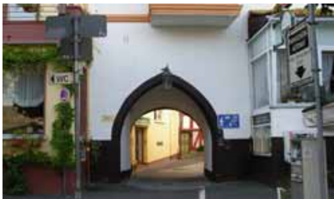
Stadteingang unter Gebäude
