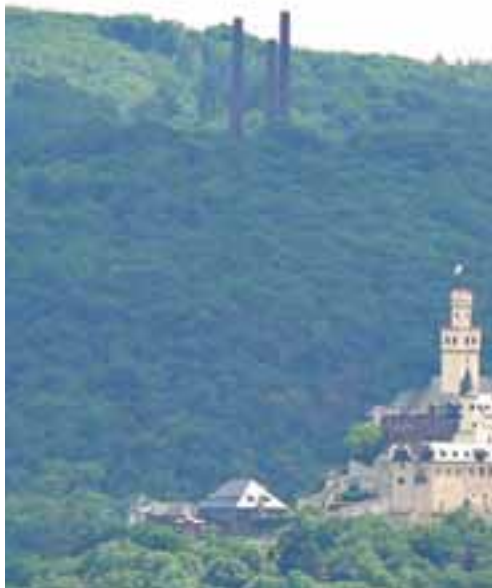
ehemaliges Blei- und Silberverhüttung, Braubach
