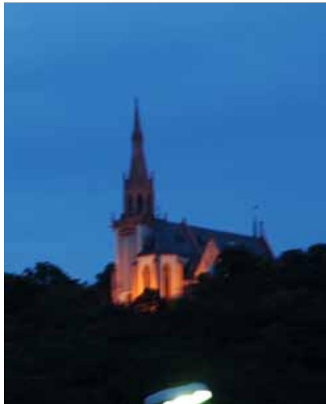
Rochuskapelle, Bingen _ fehlende Turmbeleuchtung
