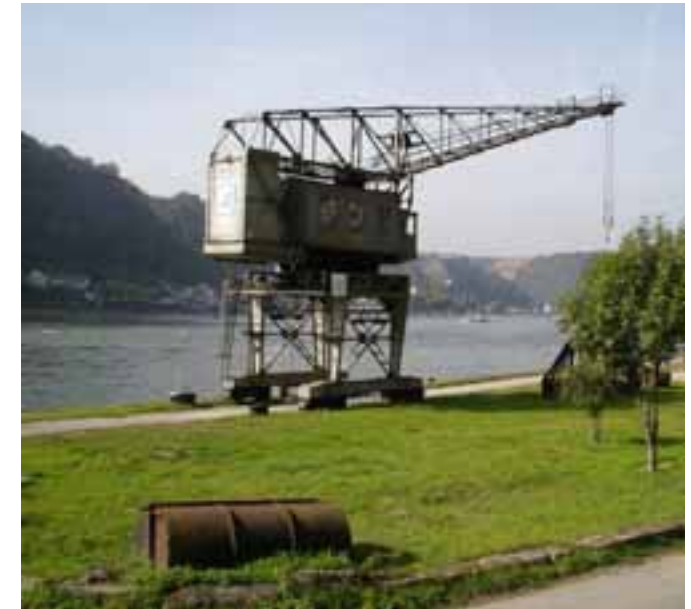
Häusener Kran, St. Goarshausen, Tagansicht
