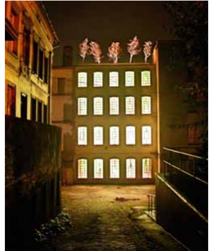
Betonung der Lochfassade
