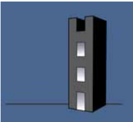
Betonung der Lochfassade
