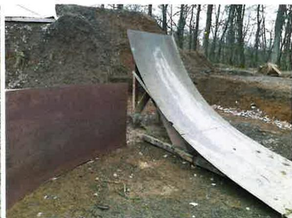
Foto 2 & 3: Drei „Kicker“ müssen dringend repariert, bzw. ausgetauscht werden. Wie auf dem Foto zu erkennen, ist das Holz teilweise stark verfault.
